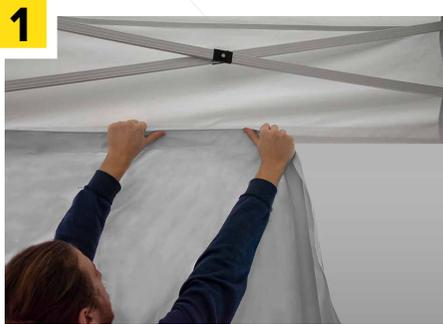
**1** Befestigen Sie die Seitenwände mittels Klett an dem in der Dachunterkante eingenähten Klettband.
